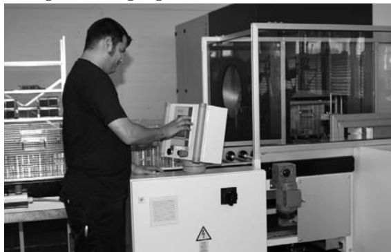
Die Reinigungsanlage «Palma» ist im spanenden Fertigungsbereich installiert
